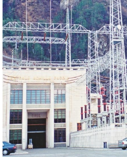
Hidro-Elektrik Enerji İstasyonu ENEL, Kuzey İtalya
